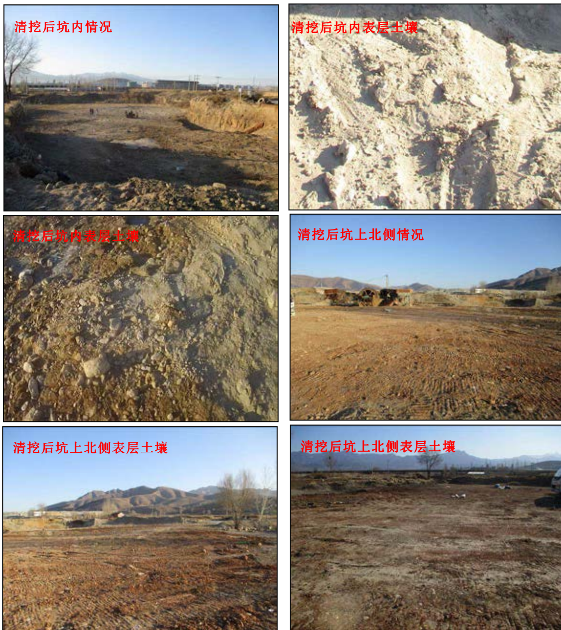
图 1-2 固体废物及污染土壤清挖、转运后现场情况
